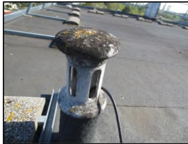
Photo N° 666 AMIANTE CIMENT -- Toiture terrasse Toiture Chapeau (Fibres-ciment)
